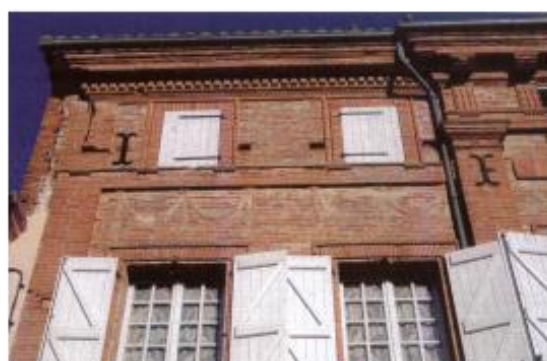
détail de la façade sur rue
