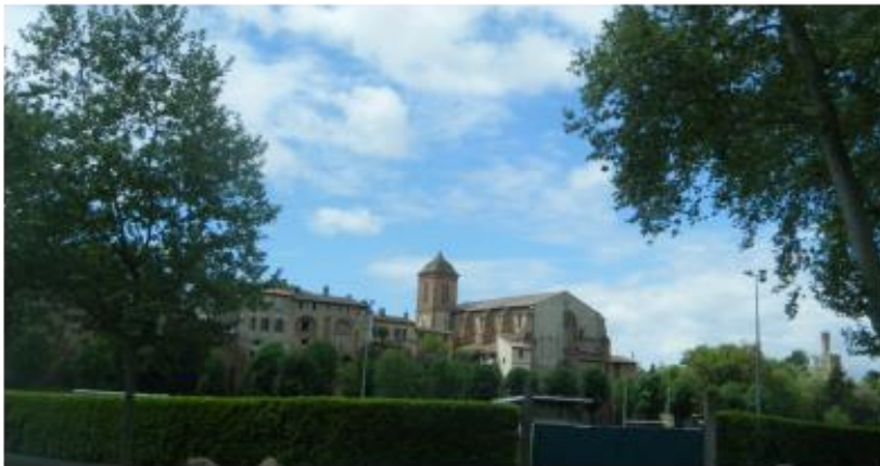
Vue vers la ville, ses ramparts, son église
